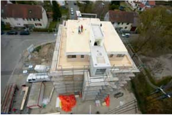
Rechts: Um den Erschließungskern aus Ortbeton wurden die vorgefertigten Wand- und Deckenelemente gruppiert
