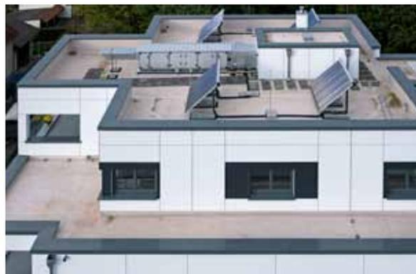
Die Röhrenkollektoren für die Warmwasseraufbereitung verborgen sind hinter der hohen Attika
